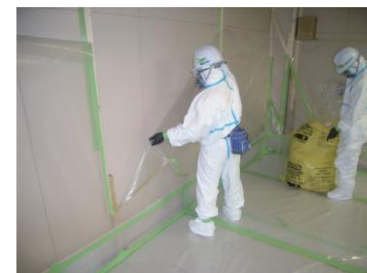
養生シートの撤去
